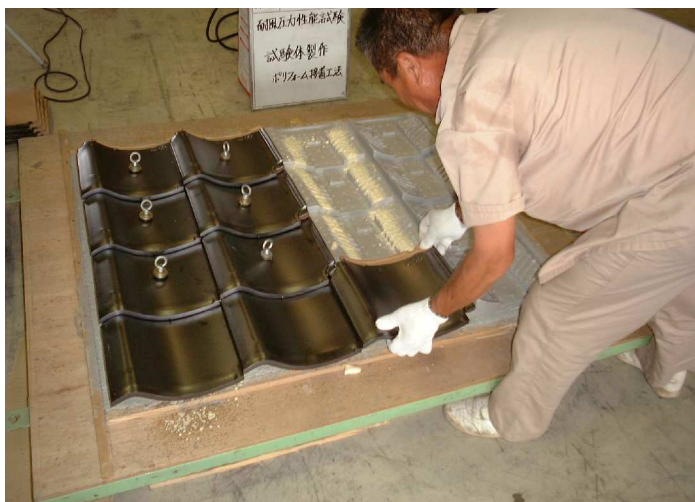
瓦を施工する
